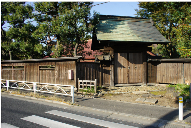
▲ 甲州街道に面して建つ本田家薬医門
