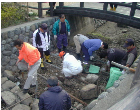
▲川に炭を設置して水の浄化を図る(2001年)
